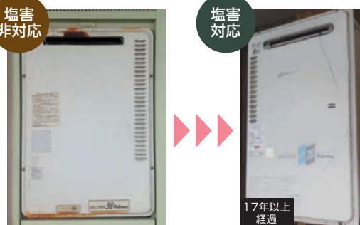
給湯器外装に塩害(サビ)に強い鋼板を使用、海辺や潮風の強い地域に推奨します。
