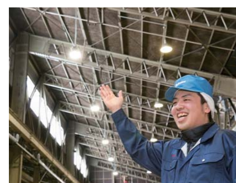
LED照明になった工場内、明るさよくなることながら電球交換の頻度が減り、保守業務の負担を低減
